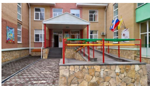
Фото № 8-11. Путь движения внутри здания
